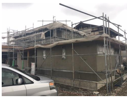
ベース施工後
