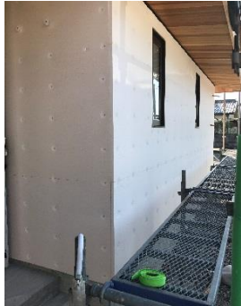
ボード施工後
