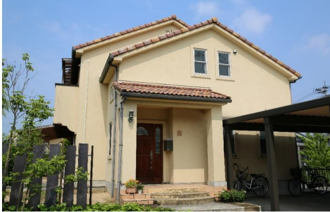
JPウォール16年目の住宅。汚れは多少あるが、ボードの劣化は見られず。
